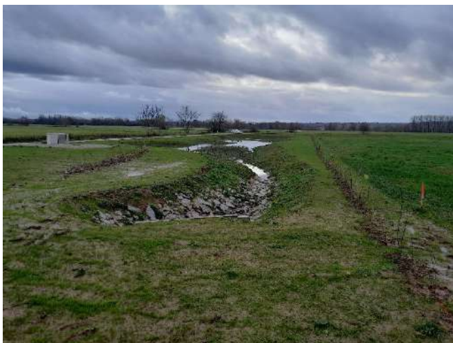
Zone de rejet végétalisé
