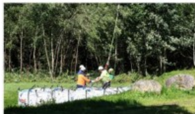
Des sacs de sable et de chaux ont été héliportés en même temps que les pièces de l'échafaudage. Photo Samuel Coulon
