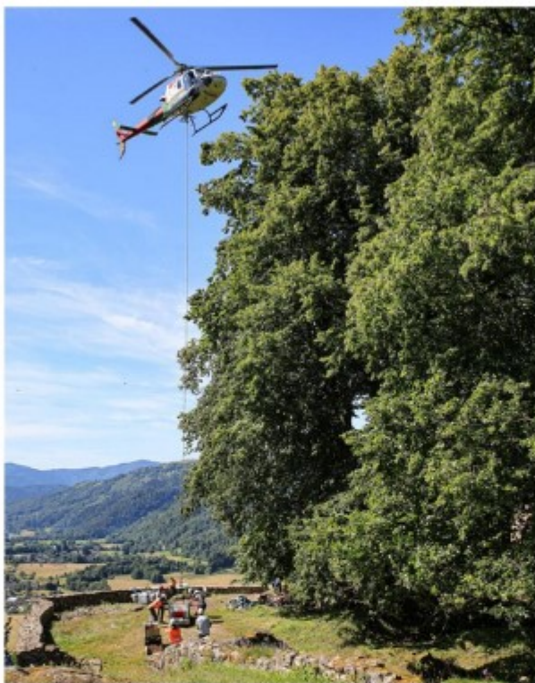
L'hélicoptère chargé de la dépose des matériaux sur le site du château de Wildenstein venait de Haute-Savoie. Photo Samuel Coulon
