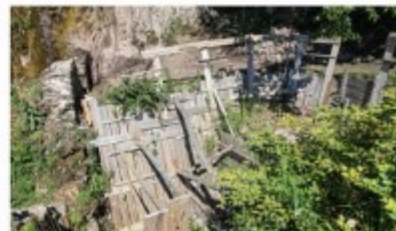
L'une des brèches dans le mur du château, devant laquelle va être installé l'échafaudage. Photo Samuel Coulon
