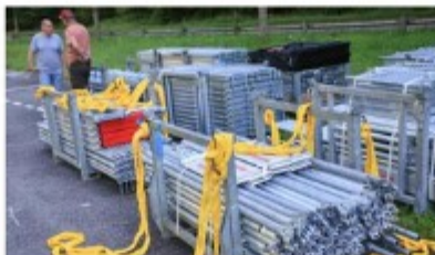
Les pièces de l'échafaudage étaient conditionnées pour ne pas dépasser 800 kg. Photo Samuel Coulon
