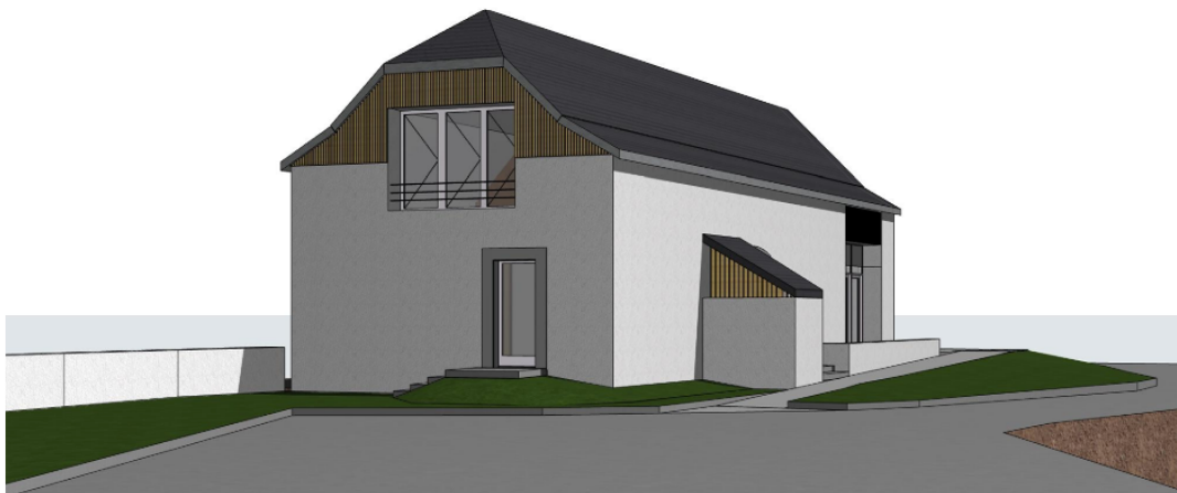
PIGNON SUD-OUEST et FACADE SUD-EST
