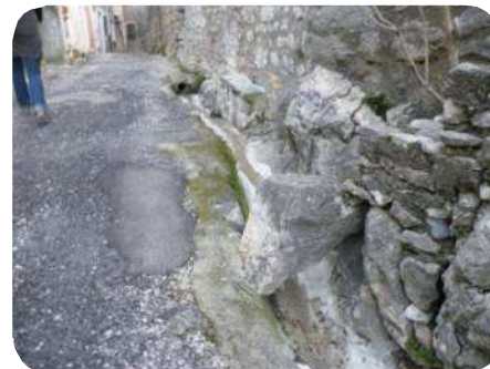
Ouvrages réseau pluvial - Brissac le Haut
