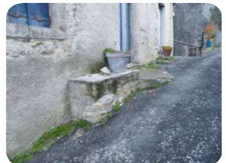
Bancs en pierres - Brissac le Haut
