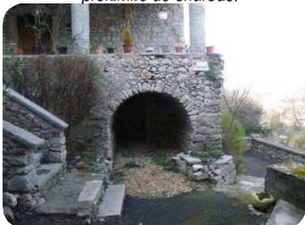
Arches en pierre à Brissac le Haut, à proximité du château.
