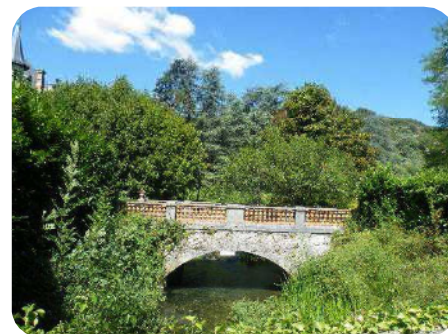
Pont au-dessus de l'Avèze, à proximité du château de la papeterie.
