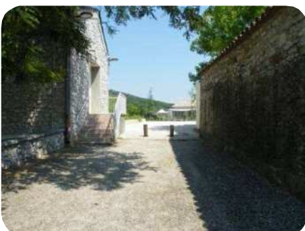
Connexion douce ponctuelle et discontinue entre la place du parc et l'école
