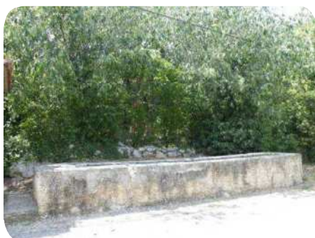
Ancien abreuvoir en pierres au hameau de Coupiac.
