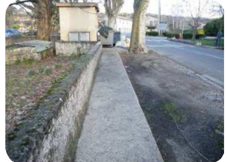
Trottoir le long de la RD4 au niveau de la Mairie
