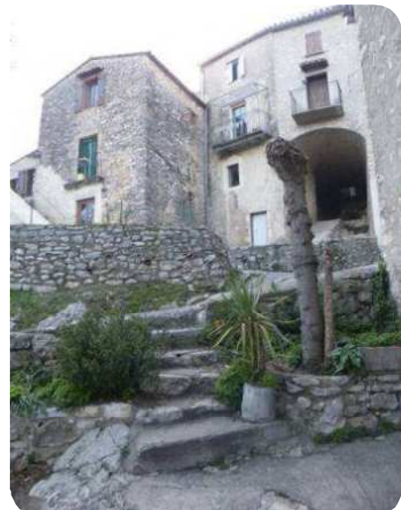
Escalier : connexion douce ponctuelle et discontinue, Brissac le Haut
