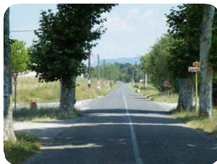
RD4 : absence de voies douces.
