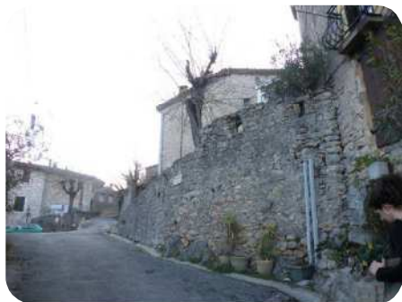
Traces de fortifications, liées à la présence du château, et témoin d'anciennes fortifications à Brissac-le-Haut.
