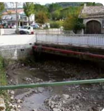
La montée de ce cours d'eau a entraîné un engrèvement du pont et une déstabilisation d'un gabion en rive gauche du ruisseau. La berge a été emportée ainsi que le gabion existant. Dès lors, la stabilité du talus routier et l'assise aval du pont sur ce site ont été menacées.
