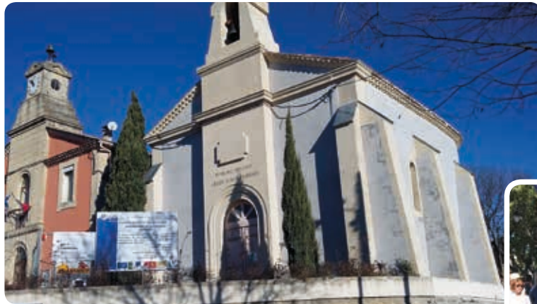
Façade du temple rénovée.
