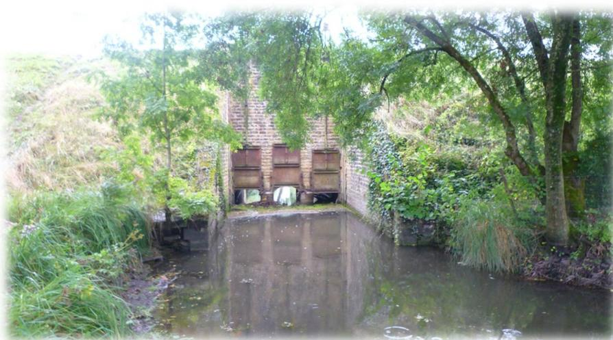
Le système d'endiguement formé par cette digue et celle de la Loire, est complété par deux stations de pompage/vannage (station de la gare et de la Daudère) qui permettent de moduler le débit des affluents vers la Loire.
