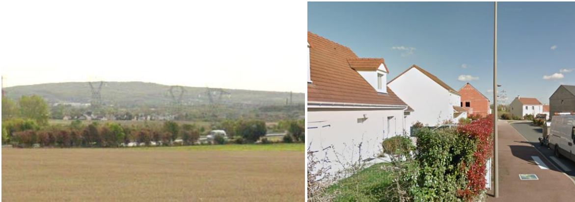
^ Rupture de l’A16 à Champagne-sur-Oise à gauche et zone pavillonnaire de Mours à droite – Source : Google Street View
