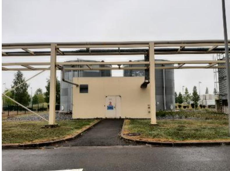
Figure 59 : Local incendie et derrière ses 2 réserves d'eau
