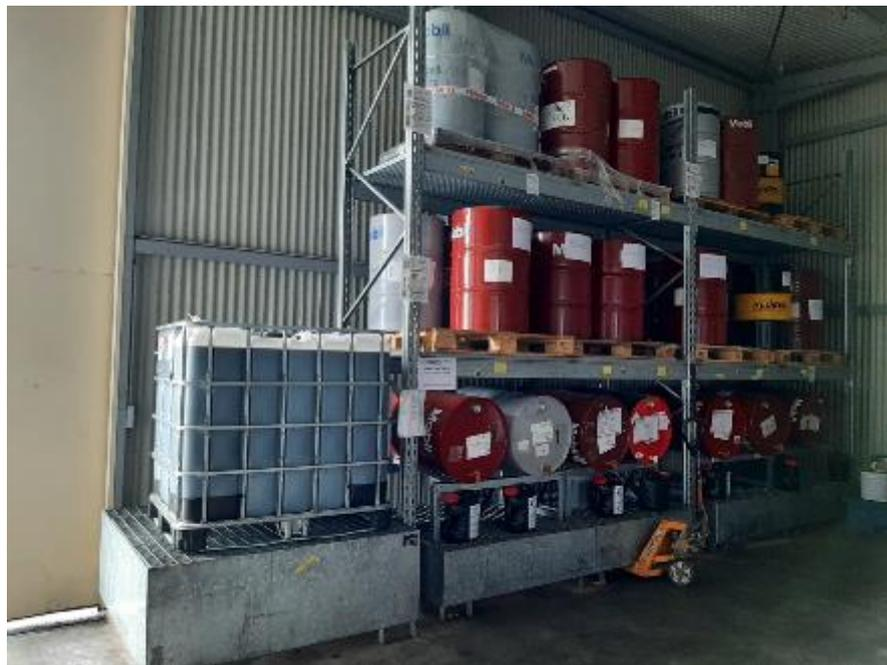
Figure 58 : Intérieur du local à huile avec bidons sur rétentions
