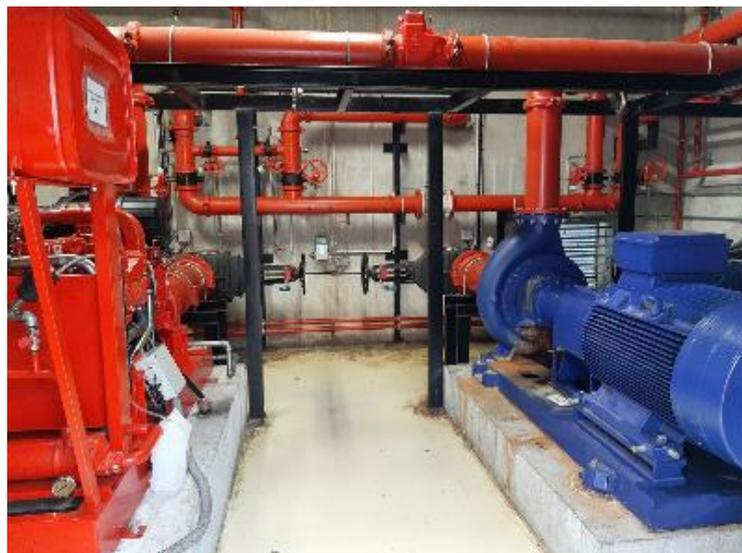
Figure 60 : Pompes local incendie connectées aux 2 cuves de 360 m<sup>3</sup>
