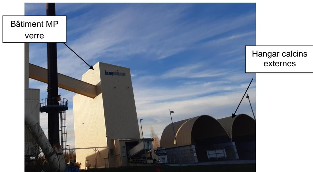
Figure 47 : Bâtiment de stockage des matières premières entrant dans la composition du verre et hangar de stockage de calcins externes
