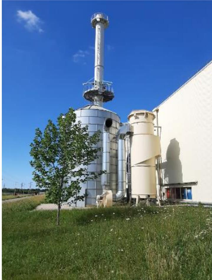
Figure 40 : En fond l'émissaire L4 (formage/broyage) et devant le silo LIMOCO avec filtration JFK et émissaire L4Ter.
