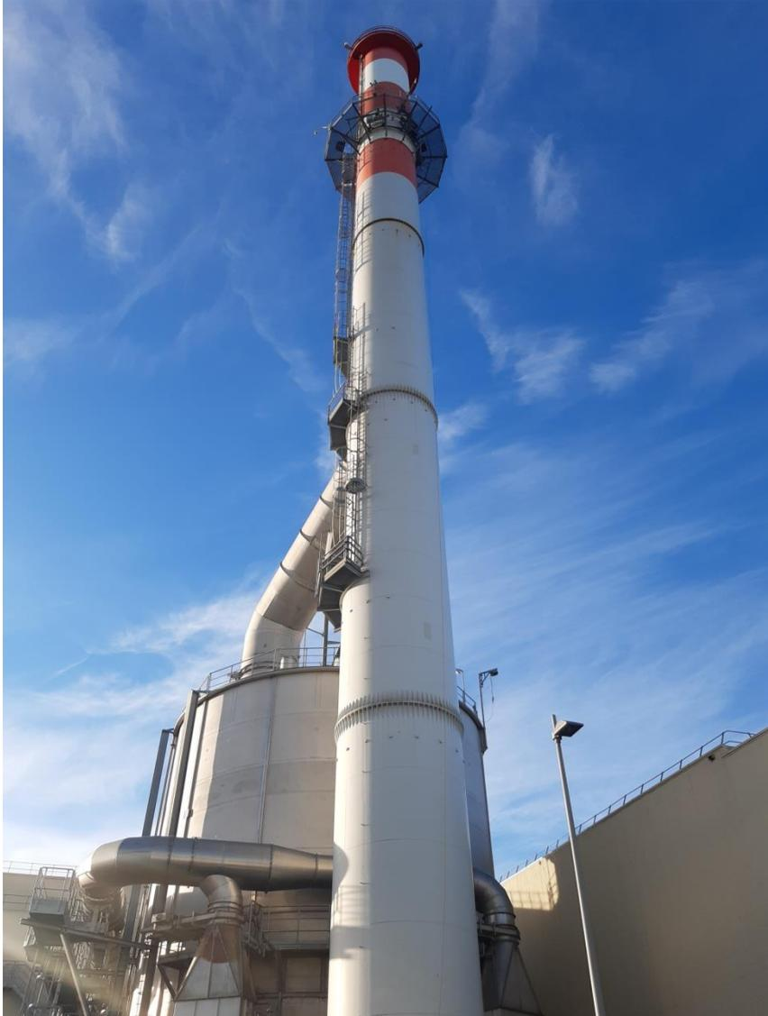
**Figure 19 : Unité de traitement des rejets atmosphériques (Electrofiltre humide)**
