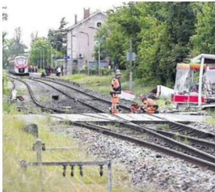
La remorque s'est retrouvée bloquée sur le passage à niveau. / DDM, M.P.V
