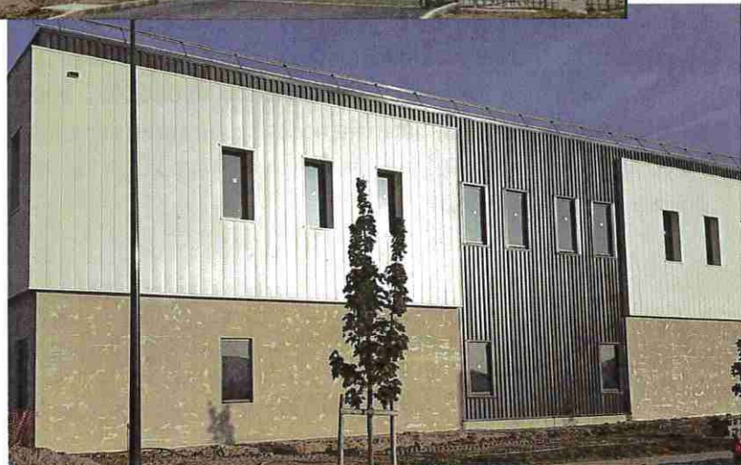
Figure 10 : ACTIPARC- Lot 9.1- Bâtiment B- en cours de chantier
