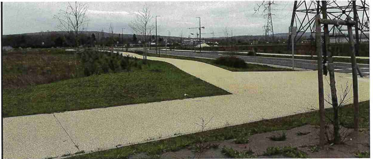
Figure 3 : Aménagement des trottoirs
