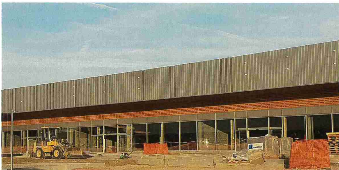
Figure 6 :Centre Parenthèses- Partie Nord en travaux
