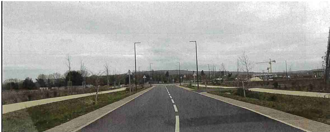
Figure1 : voie d'accès depuis le giratoire de la RD4
