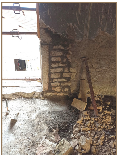
Travaux de mise en sécurité à la Salle multi-activités Robert Chambard
