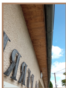
Remplacement de la frissette au groupe Scolaire.
