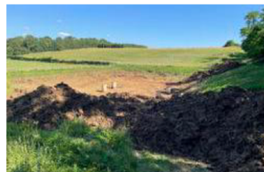
Près de 500 m 3 de terre ont été enlevés afin que le bassin retrouve sa capacité originelle de stockage. ■
