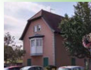
Presbytère rue Principale
