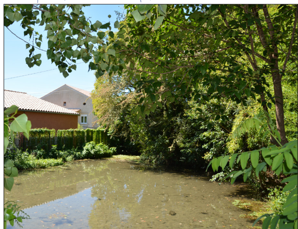
Un bassin de rétention toujours en eau au cœur d'un lotissement, accompagné de végétation hydrophile.
