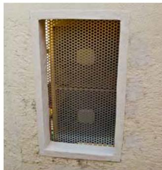
Exemple de traitement pour les échangeurs de climatiseurs.
