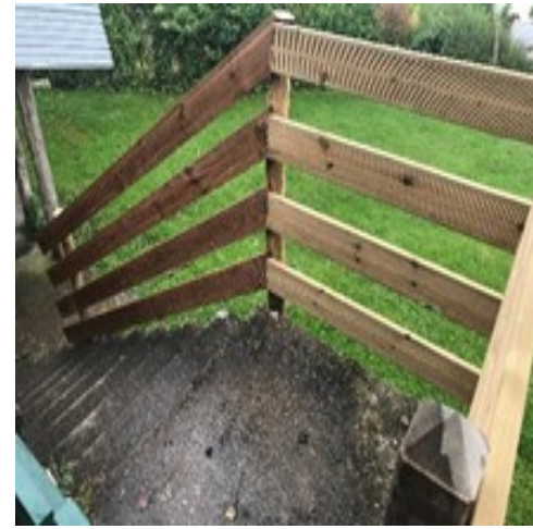
Sécurisation de l'escalier derrière la salle communale de Poumeyrol
