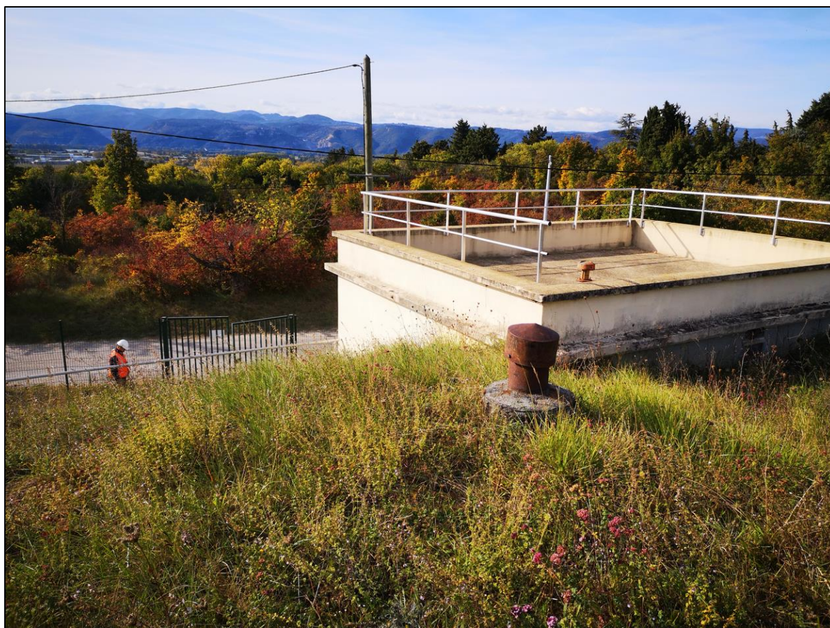
Figure 1 : Réservoir Le Colombier (Loriol-sur-Drôme)
