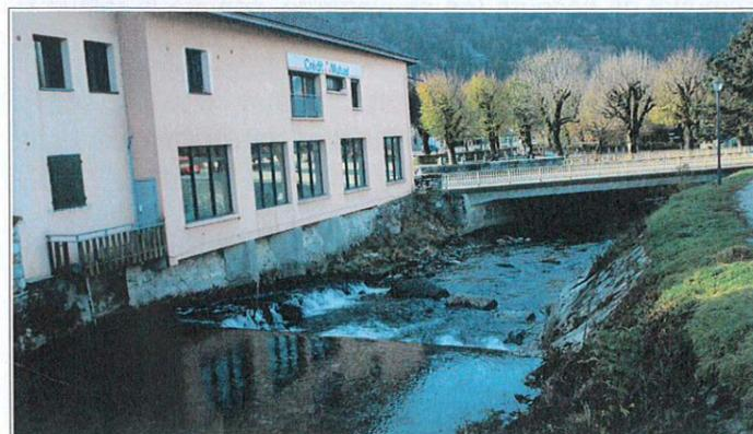
Sur la photo à gauche ci-contre, prise depuis l'amont, est visible le soubassement de l'immeuble, qui se trouve à l'aplomb de la rive gauche du Nom. On distingue après le seuil, en rive gauche et le long d'une partie de l'immeuble, une passe à poissons, puis le nouveau pont en aval.
