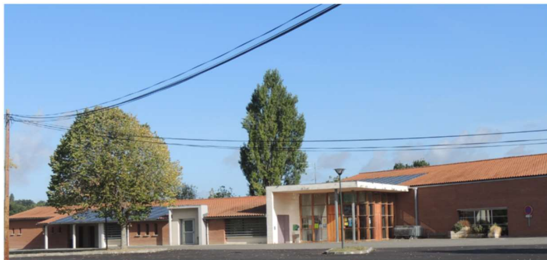
Complexe des Pyrénées – 2 Salles
