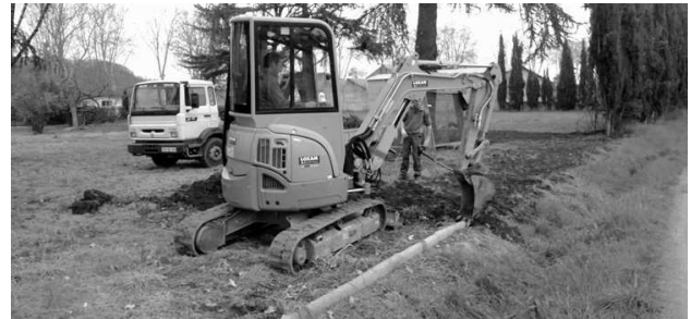
L'aménagement du petit parc, rue Tonimarié, continue : enlèvement de la clôture côté Est.
