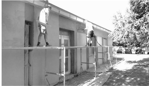
La sécheresse de 2011 avait causé de nombreuses fissures à l'extérieur et à l'intérieur du bâtiment de l'ancienne cantine. Suite à expertise, des travaux ont été réalisés en 2013 et 2014 pour traiter tous les problèmes de fissurations. Cet été l'entreprise MP construction est intervenue pour la dernière tranche de travaux liés au sinistre. Les crépis ont été refaits sur trois façades. La façade de la bibliothèque a été, pour sa part, repeinte.
