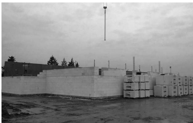
L'entreprise Probat est toujours présente sur le chantier. Le plancher bas de la partie dojo et vestiaires a été coulé. Les travaux pour la réalisation des murs sont en cours. Ceux de la salle de sport sont en béton préfabriqués, ceux du dojo et des vestiaires en siporex et les murs intérieurs porteurs en bloc béton.
