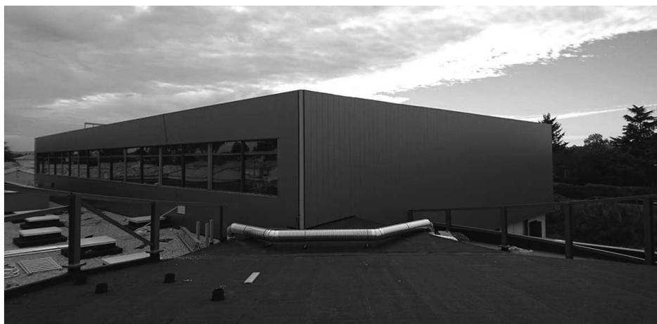
Les travaux d'isolation et de bardage de la grande halle de sport touchent à leur fin, permettant d'apprécier le visual final du bâtiment, notamment sur l'arrière, côté voie ferrée. Côté nord-ouest, une large résille d'acier, orange cuivré, marquera bientôt l'entrée principale du bâtiment. Les travaux de pose débuteront mi-novembre. A l'intérieur, l'installation des éclairages et des radiants de chauffage se terminent. Les travaux de peinture ont démarré dans les vestiaires.
