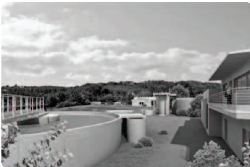
traiter l'équivalent d'une charge de pollution produite par 4 400 habitants, soit 80 m<sup>3</sup> par heure et 150 m<sup>3</sup> par heure, en pointe par temps de pluie.
