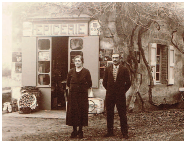
Au n°5 de la rue, l'épicerie Maurel créée en 1924 et mise en gérance en 1974 à la famille Terral. Actuellement bureau d'assurance.
