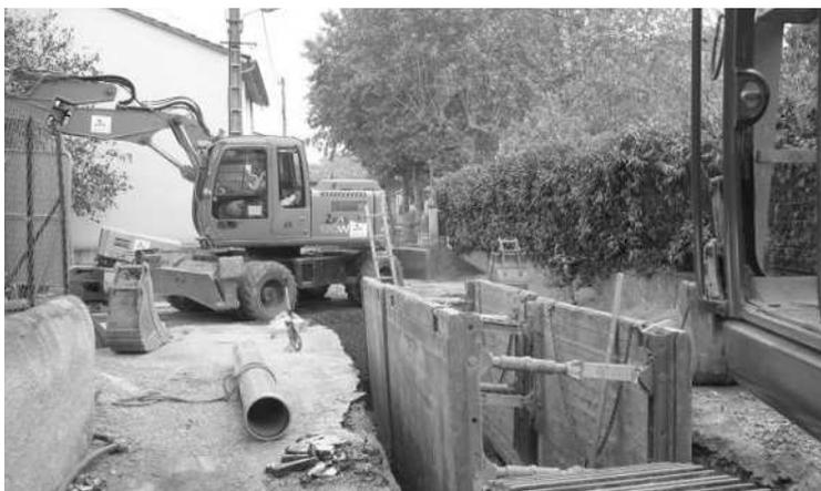
Le beau temps aidant, pas de temps perdu pour le programme de l'aménagement de la rue de l'Eglise malgré quelques surprises de début de chantier. En effet au vu de l'état des réseaux, il s'est révélé rapidement indispensable pour le Syndicat d'Adduction d'Eau Potable du Gaillacois (SIAEP) de changer la conduite d'eau potable ainsi que pour la C2A de poser un réseau d'eaux pluviales neuf, ce qui n'était
