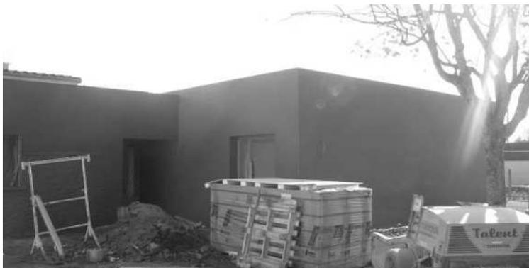
Le bâtiment est maintenant hors d'air, hors d'eau. L'entreprise Pailhe a terminé les enduits des façades et à l'intérieur les travaux d'électricité et de platerie sont en cours ; les derniers travaux consisteront à aménager les sanitaires, la kitchenette et les placards destinés aux associations.
