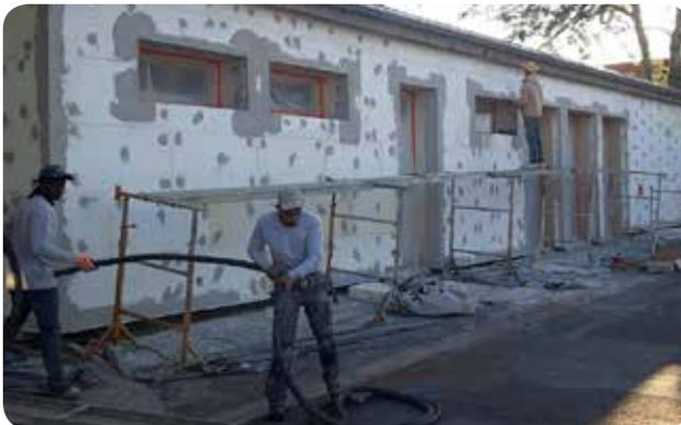
Travaux de rénovation énergétique à l'ancienne cantine : isolation par l'extérieur par l'entreprise ISOBTP 81
