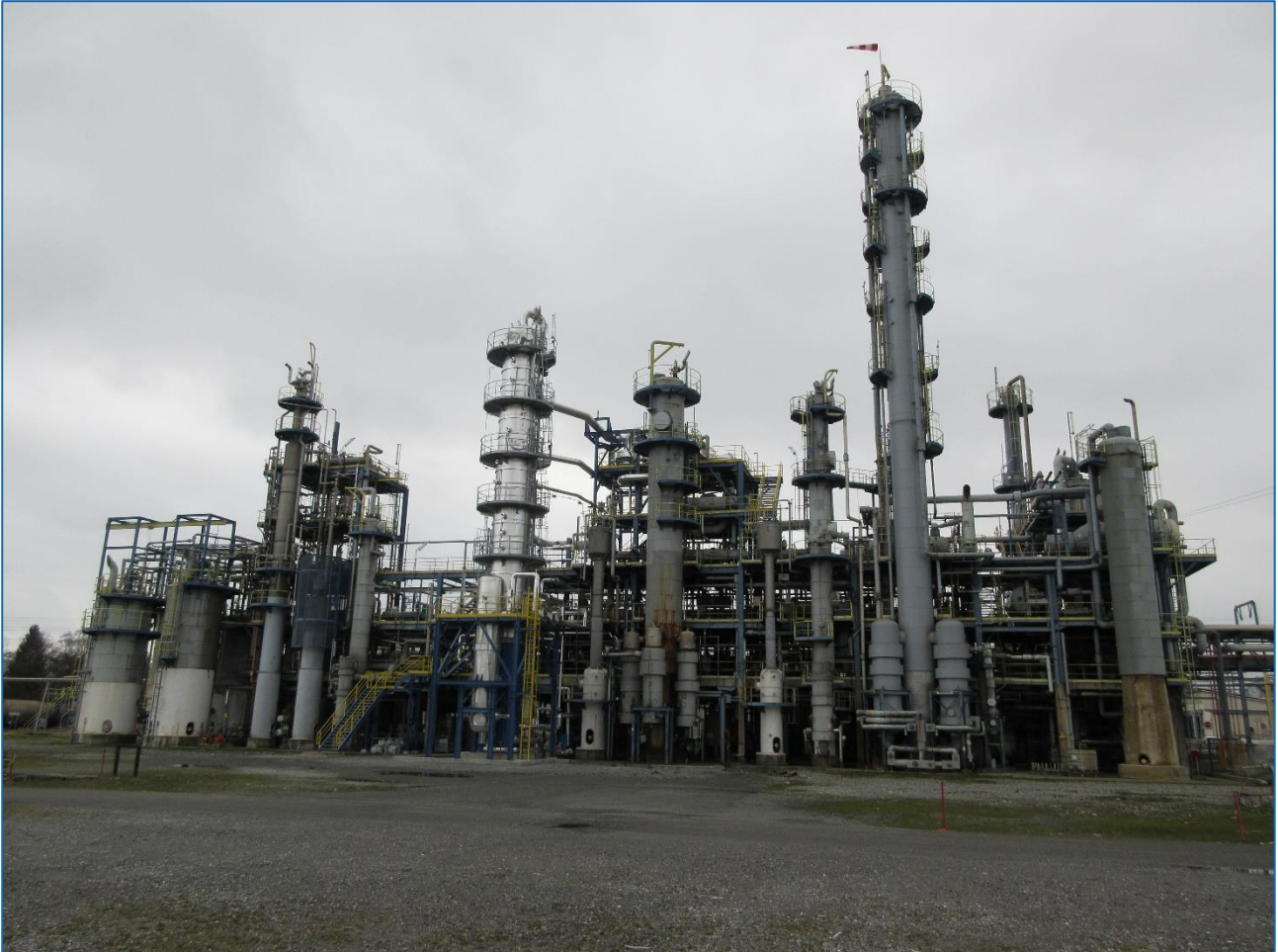
Figure 5 : Photographie de l'atelier Hydrate d'Hydrazine
