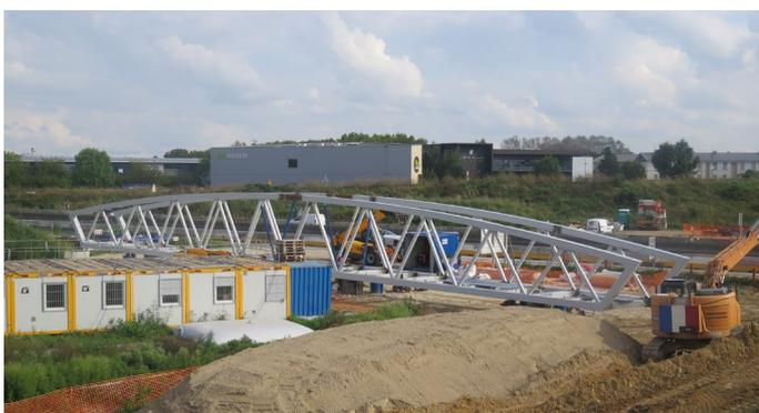
L'ouvrage été acheminé à son emplacement. Ses tronçons sont actuellement joints les uns aux autres sur place. L'ensemble sera posé au-dessus de la A4 début octobre. Les travaux sont dirigés par la Sanef pour Marne et Gondoire. L'ouvrage mesure 42 mètres de long pour 3 mètres de largeur utile. Piétons, cyclistes et cavaliers de la police montée pourront l'emprunter. Une voie verte sera aménagée de part et d'autre.
