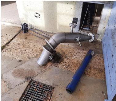
Renouvellement rotor stator cône de compression de la pompe gaveuse et réparation de la vis.
