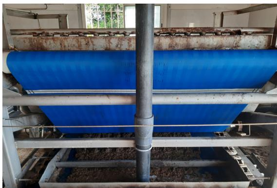
Cette année une toile a été remplacé sur le filtre bande. Les buses de lavage, deux paliers de roulement ainsi que les distributeurs d'air ont aussi fait l'objet d'un renouvellement.
