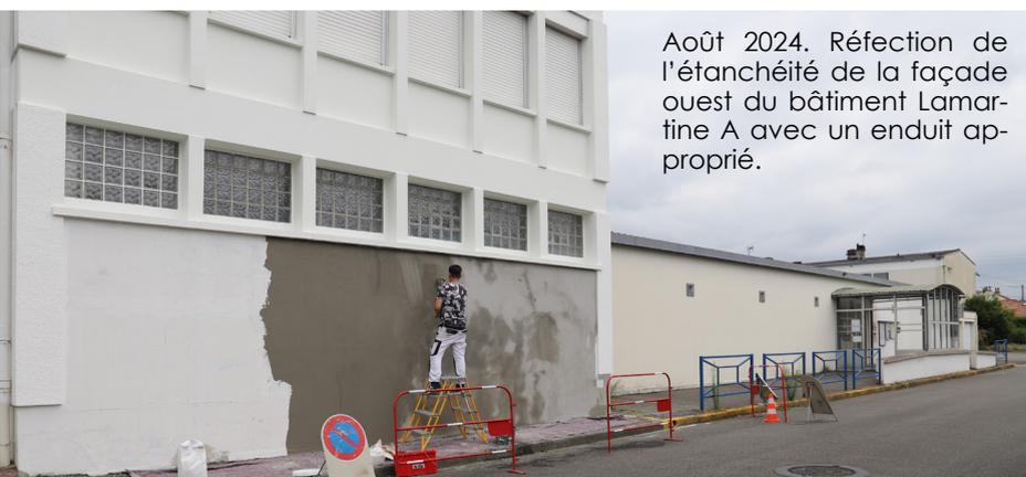
Août 2024. Réfection de l'étanchéité de la façade ouest du bâtiment Lamartine A avec un enduit approprié.
