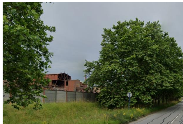
Figure 36 Vue le long de la rue Poincaré dans le sens Amnéville - Rombas (n°2)
