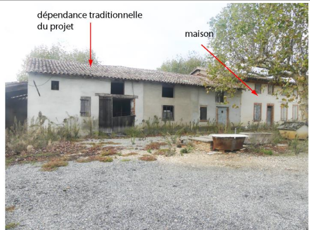
Façade sud-est (étable et maison)
