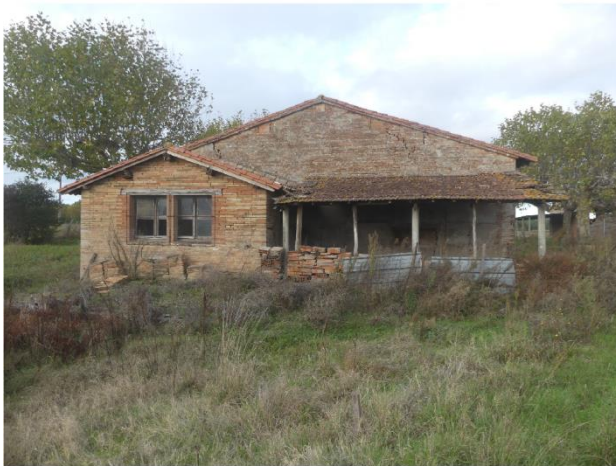
Façade sud-ouest (appentis et étable)
