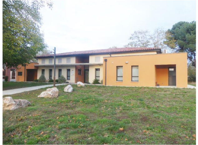
Maison médicale, façade ouest
