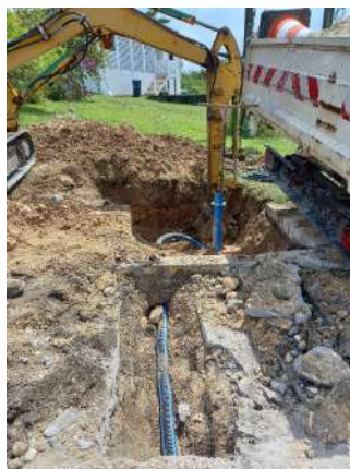
Photos : Actes courants d'Exploitation avec terrassement (renouvellement de branchement, branchement neuf, réparation fuite)
