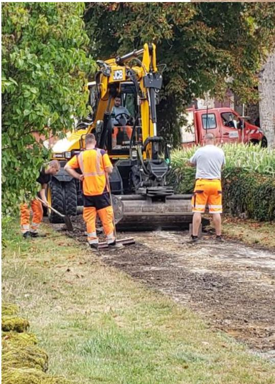
Travaux de point à temps (PAT) réalisés sur diverses voies de la commune par l'entreprise Eiffage.
