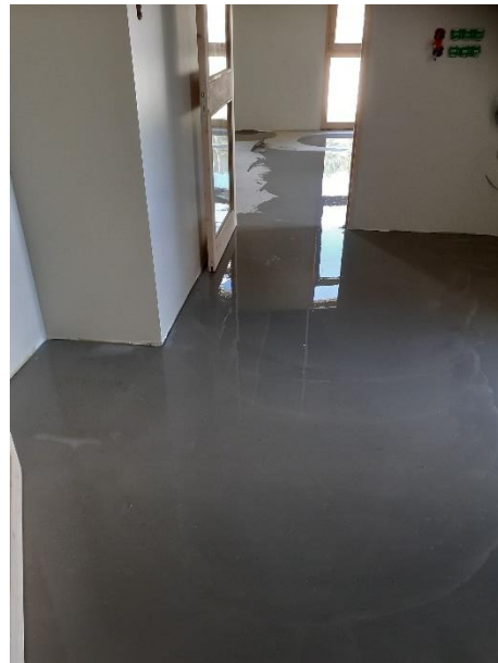
Réagréage des sols avant pose du marmoleum
