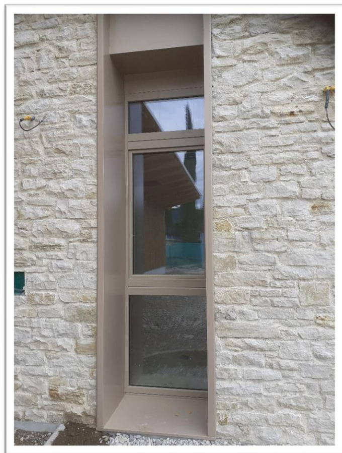
Pose des habillages des menuiseries extérieures
