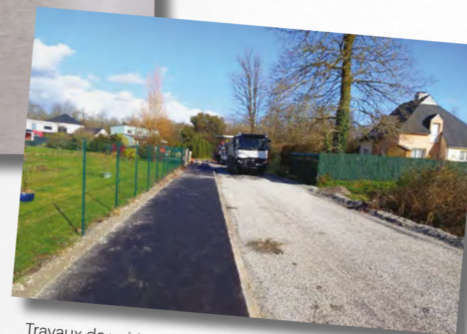
Travaux de voirie rue Dom Guillaume-allée du Verger et trottoirs rue de Brocéliande
