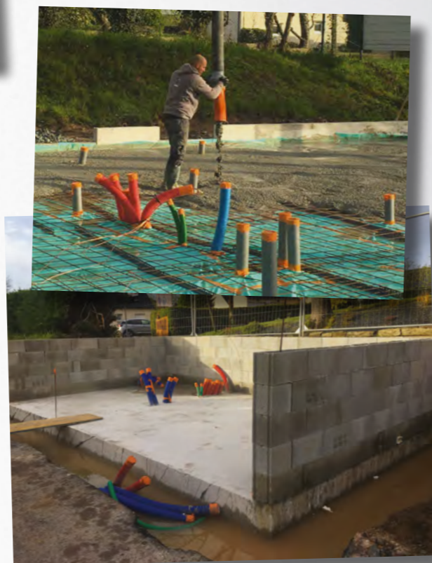
Les travaux des halles commerciales avancent !
