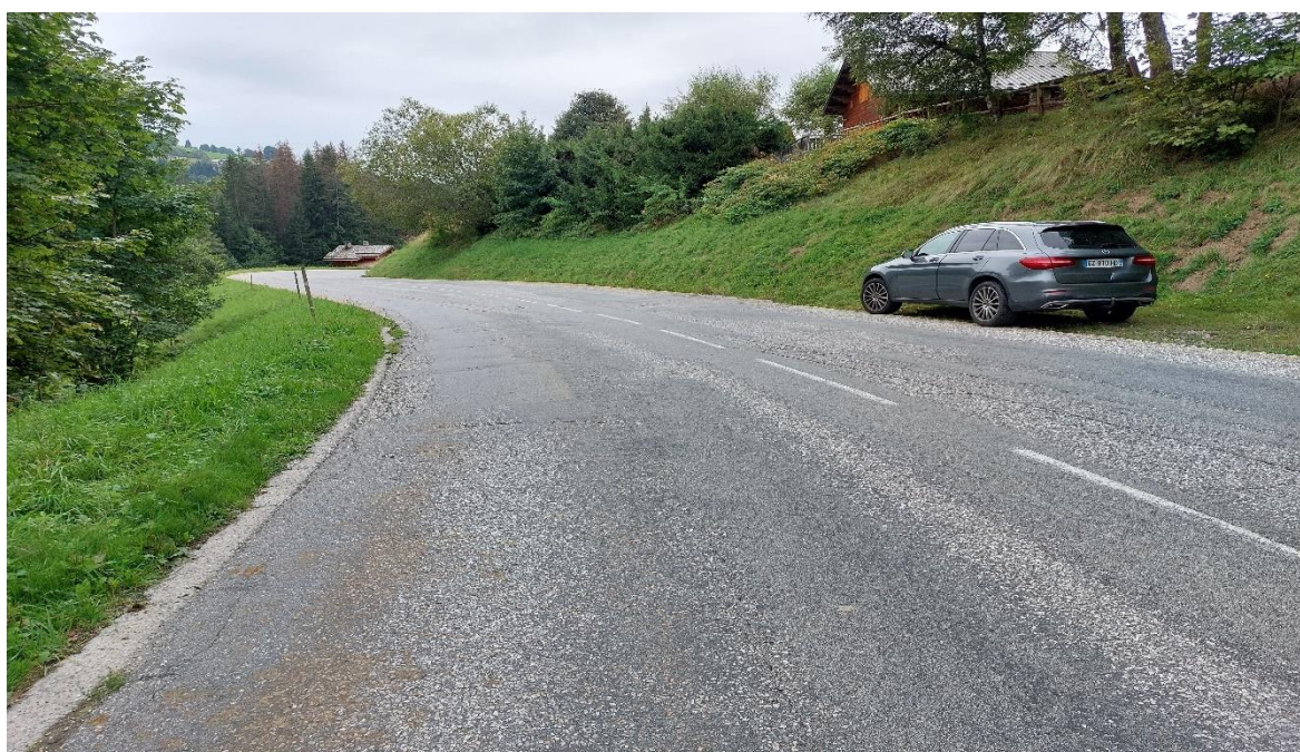
Vue sens descendant de la route départementale 218B
