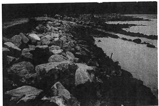
Vue générale de l'enrochement depuis le nord
