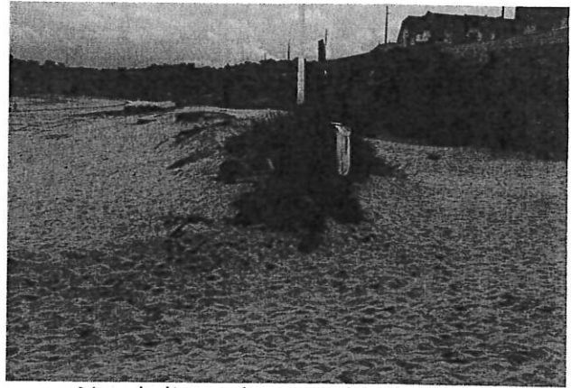
Vue de l'enrochement depuis l'ouest
