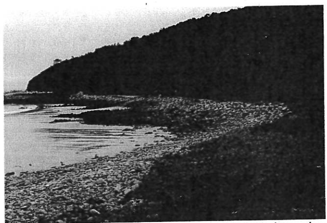
Vue générale de l'enrochement depuis le sud
