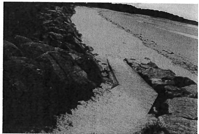
Vue de la rampe est
