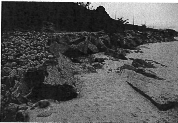
Vue de l'enrochement depuis l'est
