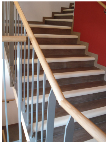
La cage d'escalier
