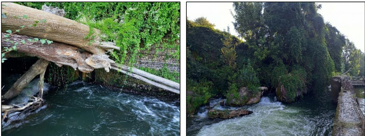
Figure 10 - Vue de la voûte amont et de l'aval du chenal de l'écluse
