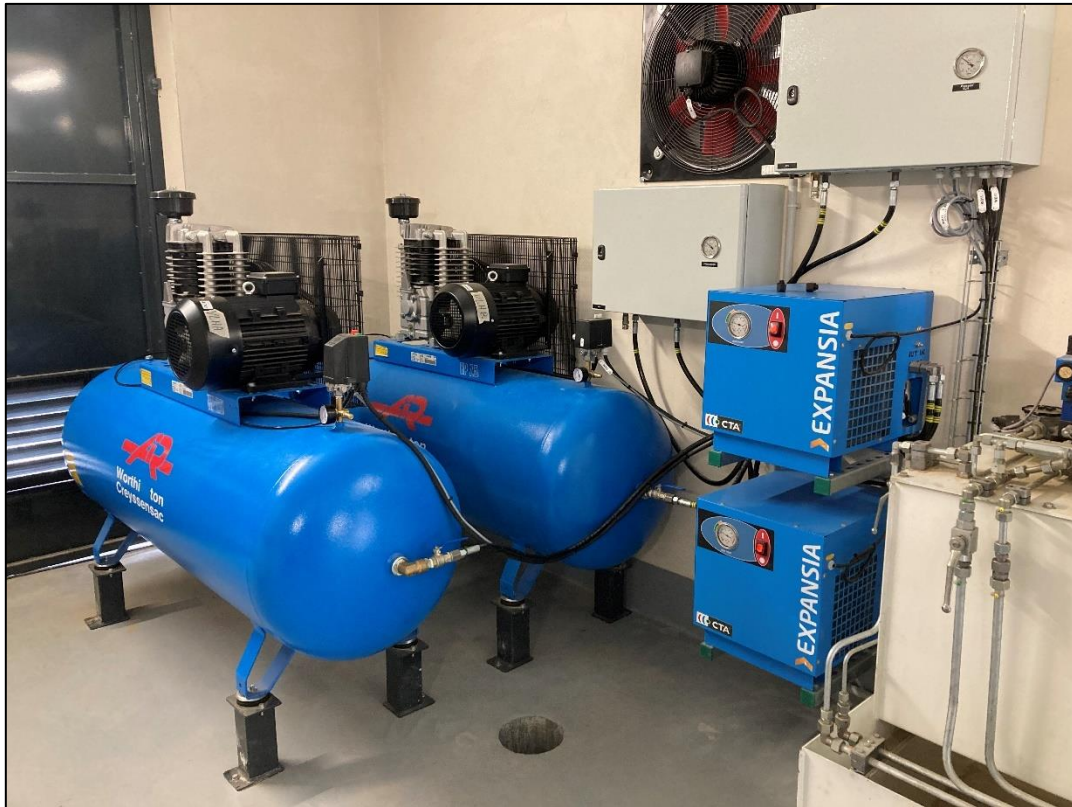
Figure 39 - Exemple de compresseurs et assécheurs d'air
