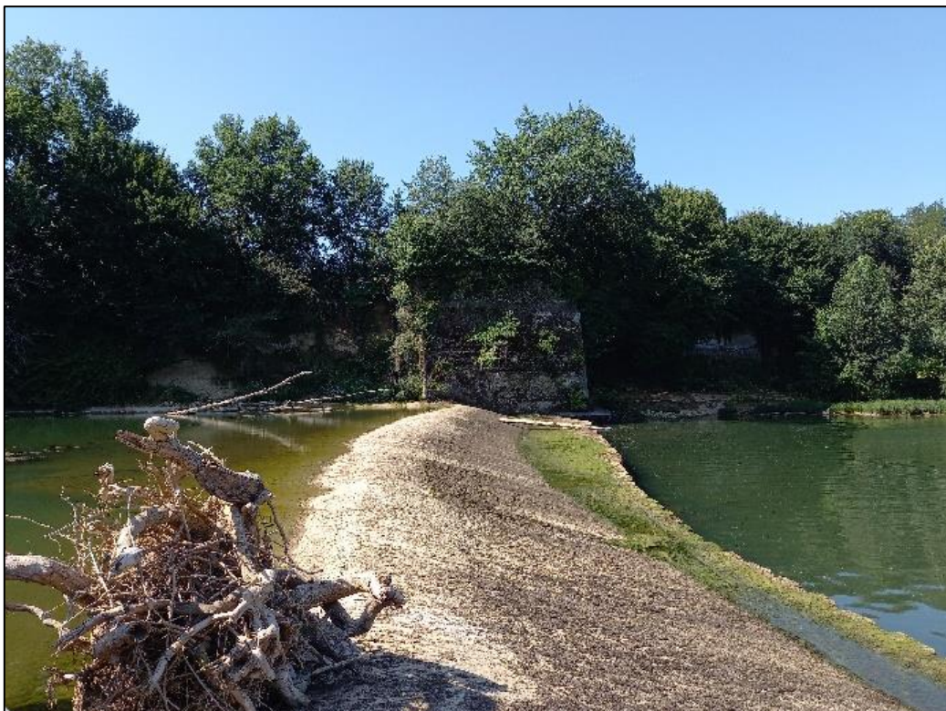
Figure 4 - Seuil, vue rive gauche
