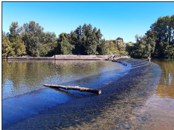
Aval du seuil de l'Escalire
