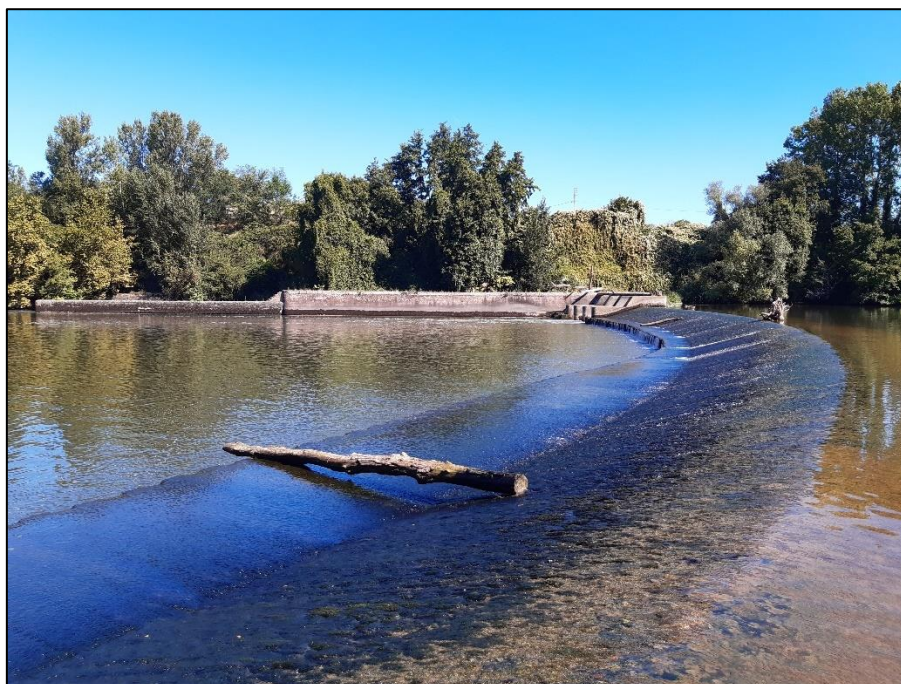
Vue du seuil
