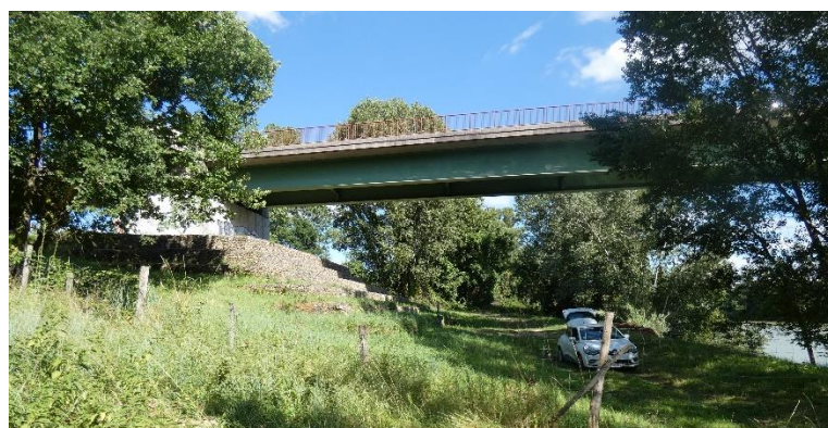
Figure 25 : Pont de l'Escalaira
