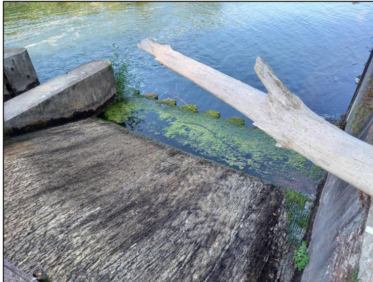
Figure 8 - Vue du seuil vers l'aval depuis la crête
