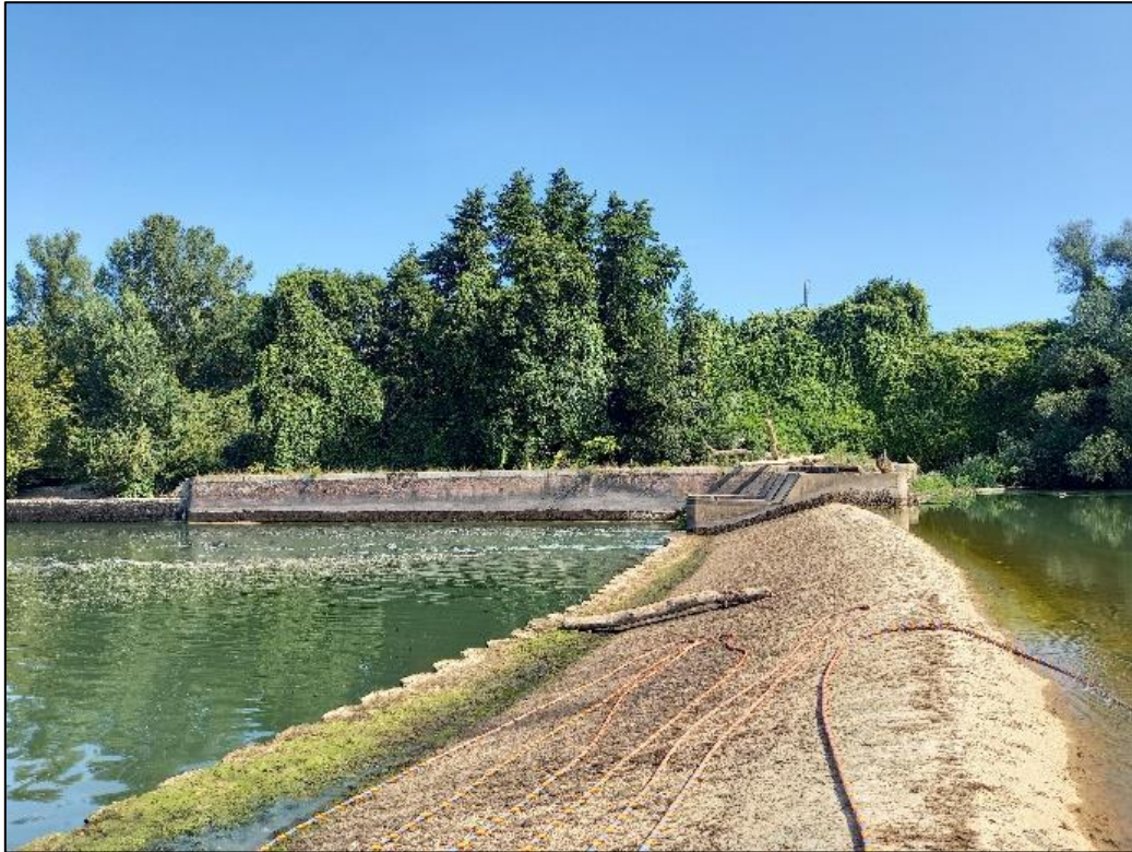
Figure 3 – Seuil, vue rive droite
