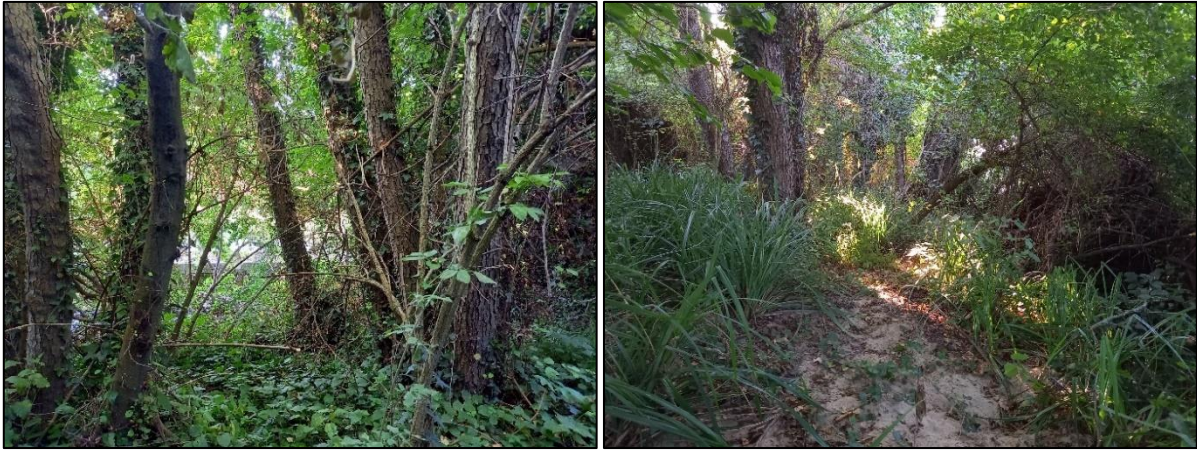
Figure 11 - végétation sur les ouvrages
