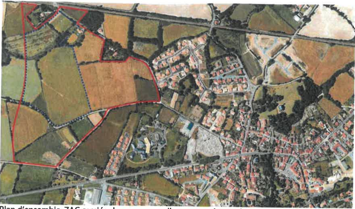
Plan d'ensemble, ZAC cerclée de rouge, parcelles concernées par l'intervention de l'EPF cerclées de bleu
