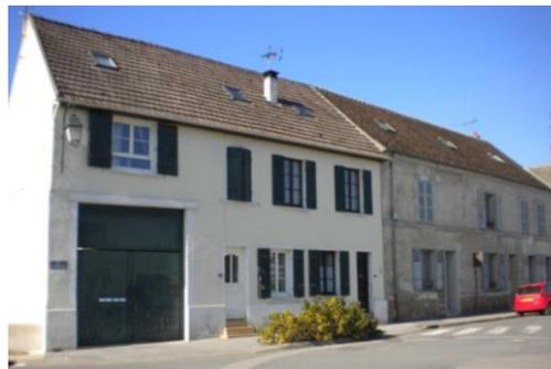
Les enduits de plâtre ou de chaux sont plastiques et souples. Ils protègent le mur tout en lui permettant de respirer. Imperméables à l'eau et perméables à l'air, ils sont un bon isolant thermique régulateur d'humidité.
