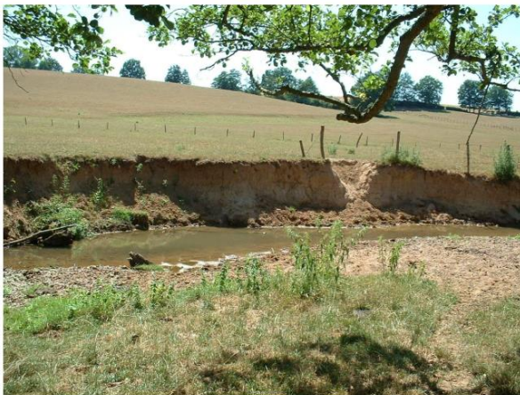
Figure 37 : Éroston au droit d'une prairie sur le Sornin aval
