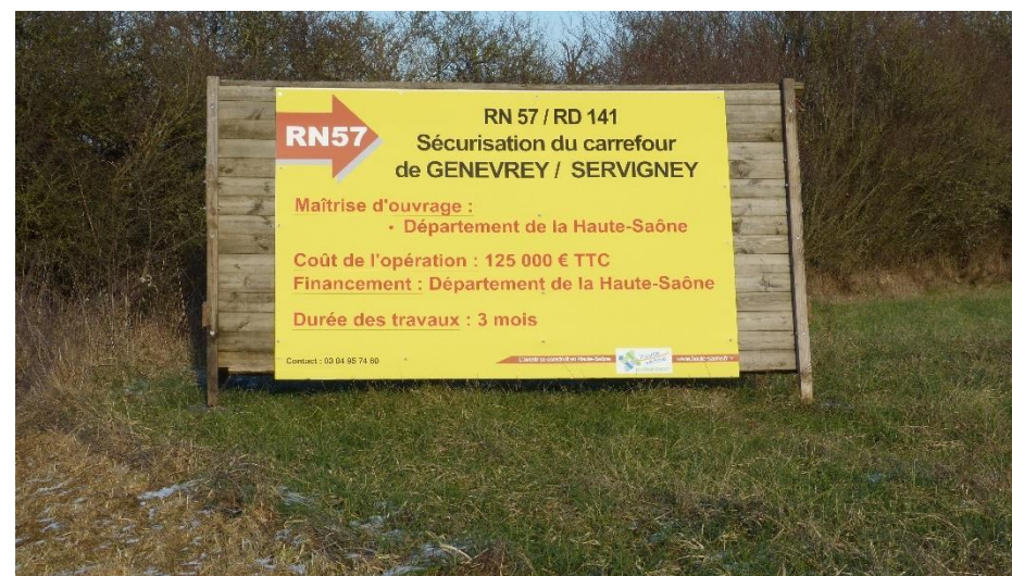
Affiche des travaux menés sur le carrefour (source : IAD)
