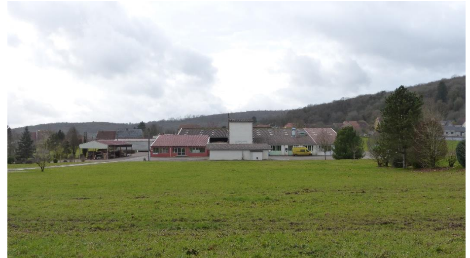
Menuiserie à Cerre-lès-Noroy (source : IAD)
