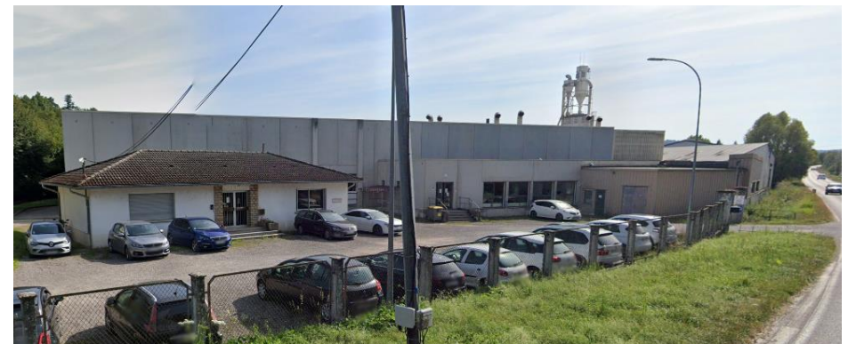
Saônoise de contre-plaqué à Villers-lès-Luxeuil (source : Google)
