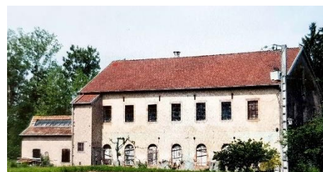
Ancienne filature – Citers (source : Patrimoine industriel de la Haute-Saône)
