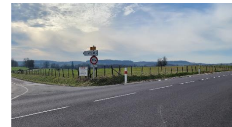
Entrée de la CCTV carrefour de la RN19 vers Mollans – absence d'identité de la CCTV
