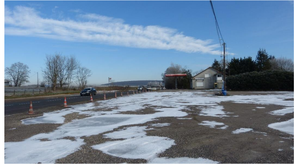
Station-service et restaurant à Velleminfroy (source : IAD)
