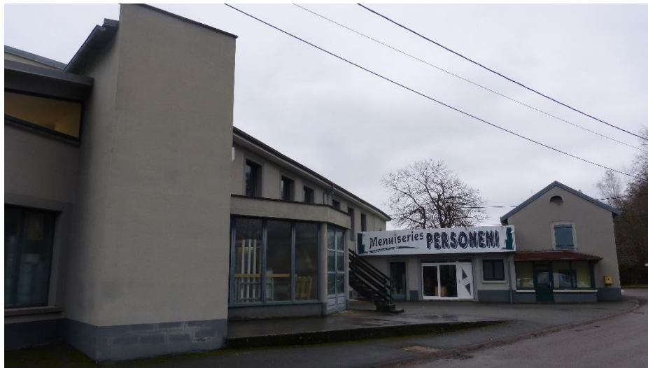
Menuiserie à Linexert (source : IAD)
