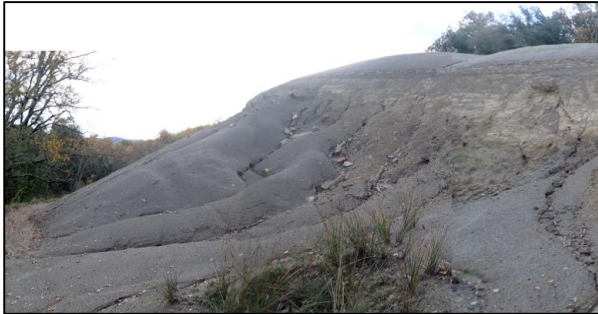
Digue à "stériles" (résidus de traitement)
