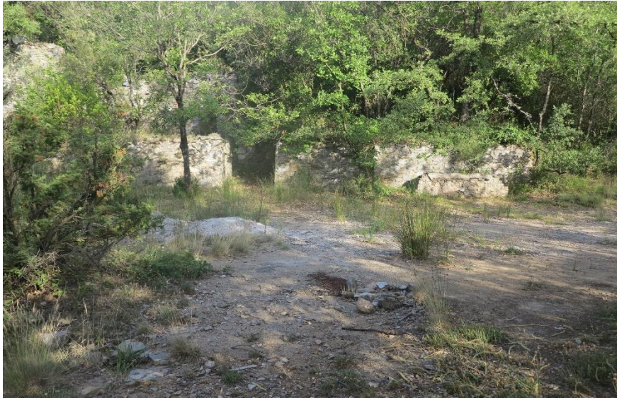
Figure 97 : Bâtiments de la laverie de Fressac. Le sol est couvert de résidus de traitement fins
