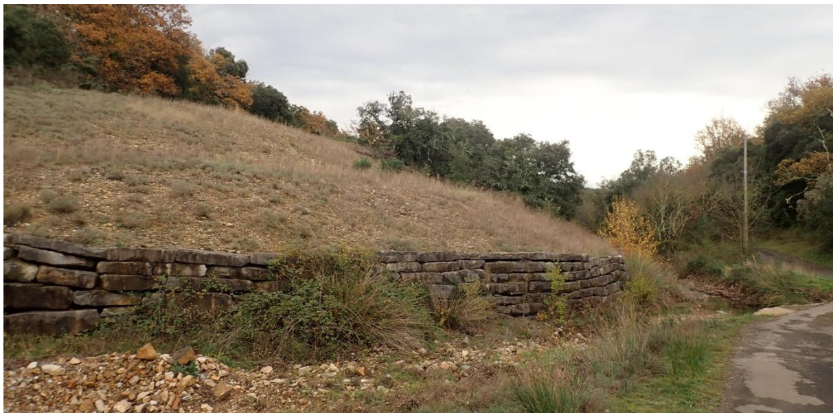
Figure 88 : Vue sur le talus stabilisé des haldes de laverie, et sur le mur de soutènement situé à la base.
