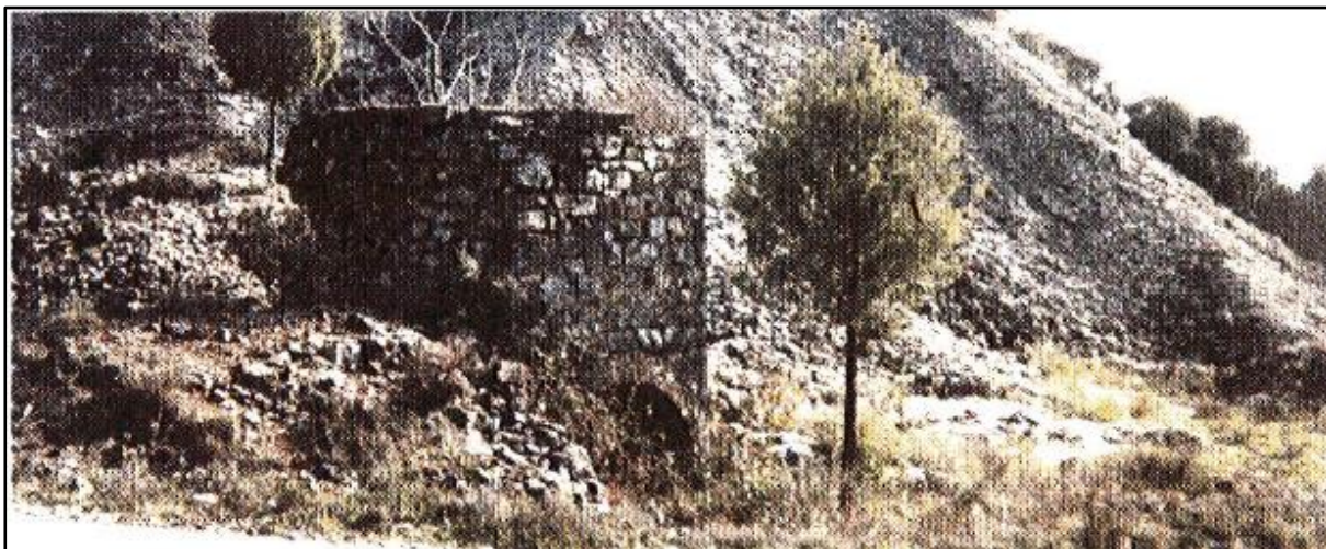
Figure 30 : Haldes de laveries avant réaménagement en 1994
