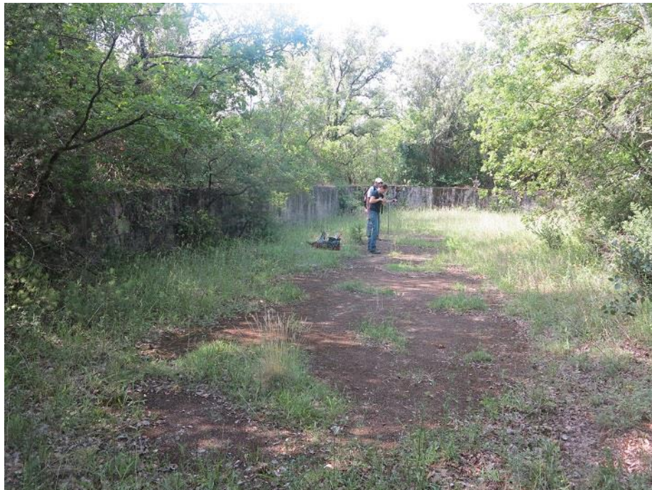
Figure 43 : Vestige du bassin de décantation de la laverie de Fressac
