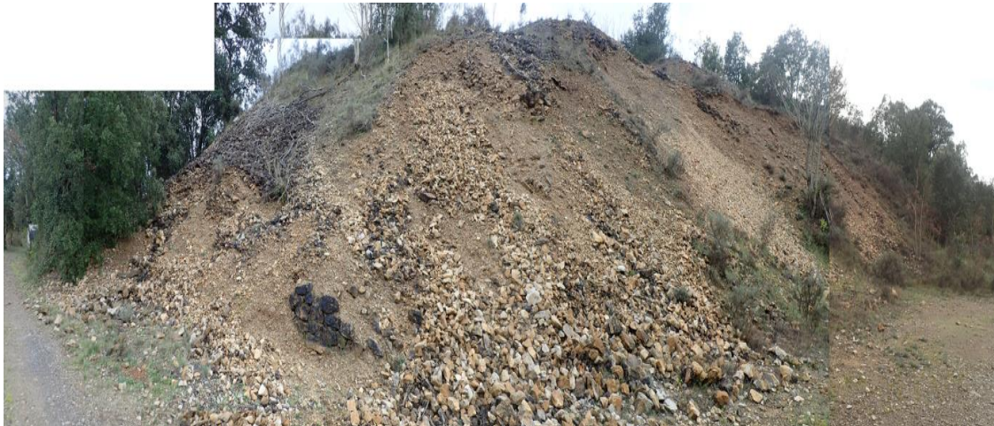
Figure 94 : Vue sur les haldes de stériles de creusement formant un talus instable en contrebas de la mine à ciel ouvert de Lacoste
